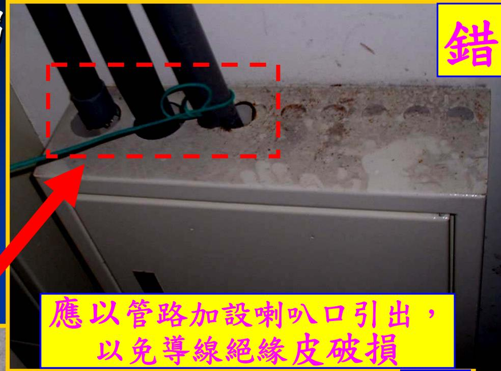
應以管路加設喇叭口引出，以免導線絕緣皮破損
