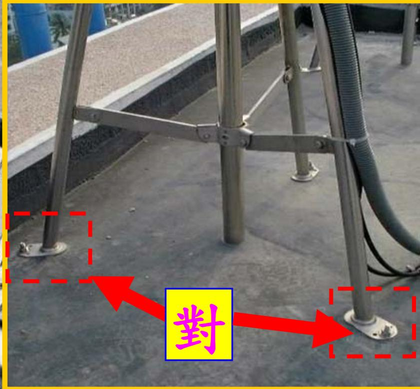
屋頂電纜線之引進管，須加設**防水彎**避免**雨水**進入。
