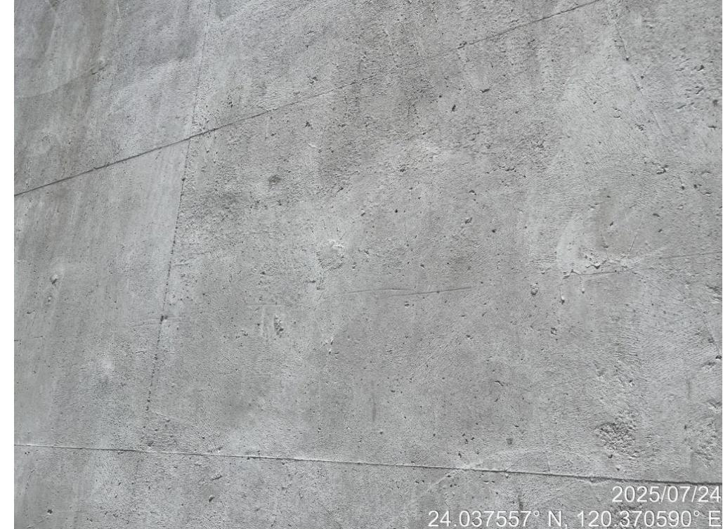
正確-用剪鉗或砂輪機將混凝土表面突出之鐵件、雜物等清除至與混凝土面齊平
