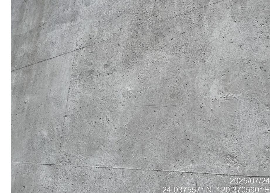
**正確**-用剪鉗或砂輪機將混凝土表面突出之鐵件、雜物等清除至與混凝土面齊平
