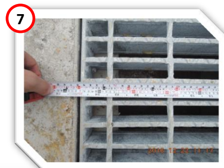
集水井開口寬度為70cm，設計圖不符。
