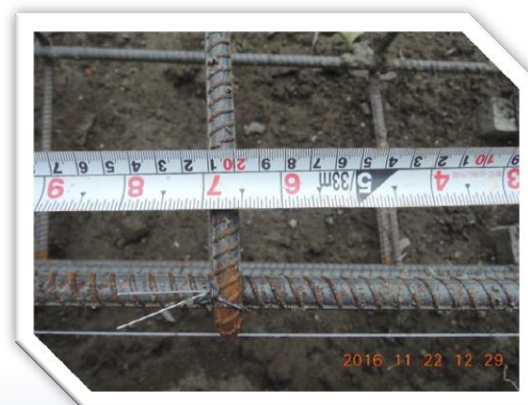
鋼筋間距量測
