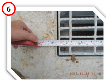
鍍鋅隔柵板寬度為80cm，設計圖不符。
