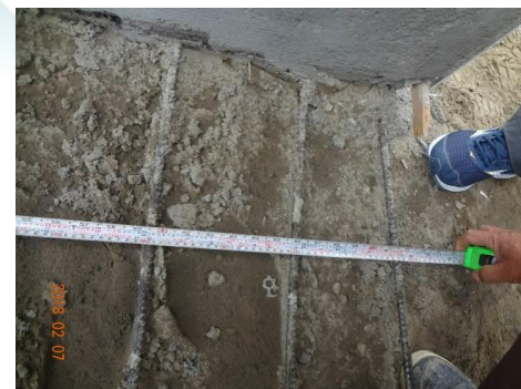
鋼筋間距檢測
