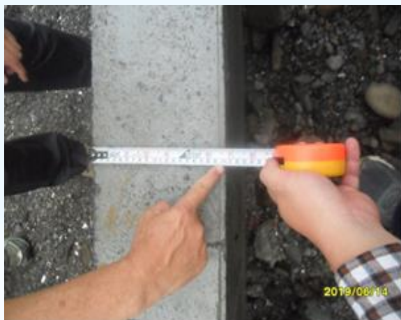
排水溝厚度量測
