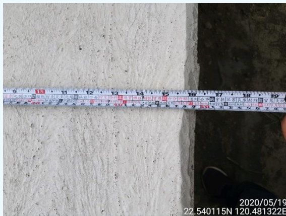
混凝土牆厚度量測
