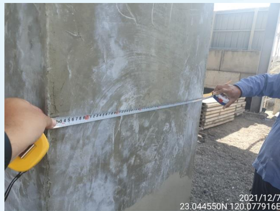
混凝土牆厚度量測
