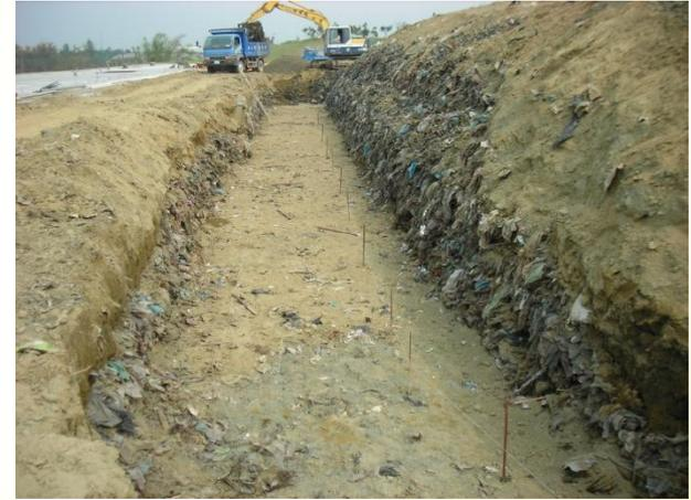
右側擋土牆基礎挖方
