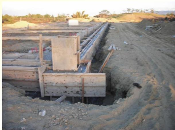
水溝混凝土澆置
