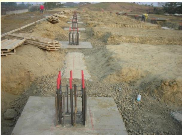
柱筋及混凝土澆置完成
