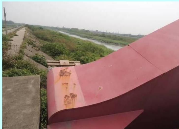
預防方法：採氧氣乙炔切割，預留距母材面 $3 \sim 5 \text{mm}$ 高度，再採電動砂輪機磨平，經研磨後補漆。
