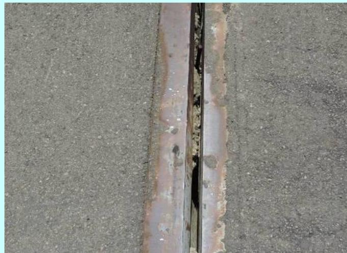
預防方法：伸縮縫應有排水設施，可①採用排水導溝方式，避免雨水伸縮縫滲入鋼梁，②支承墊加裝防（雨）塵套。
