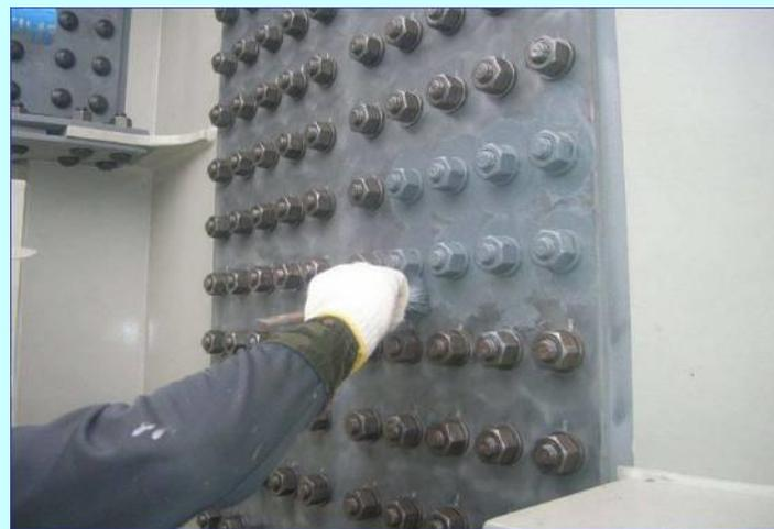
預防方法：螺栓表面確實去油脂，塗膜厚度符合，扭斷型螺栓研磨銳角
