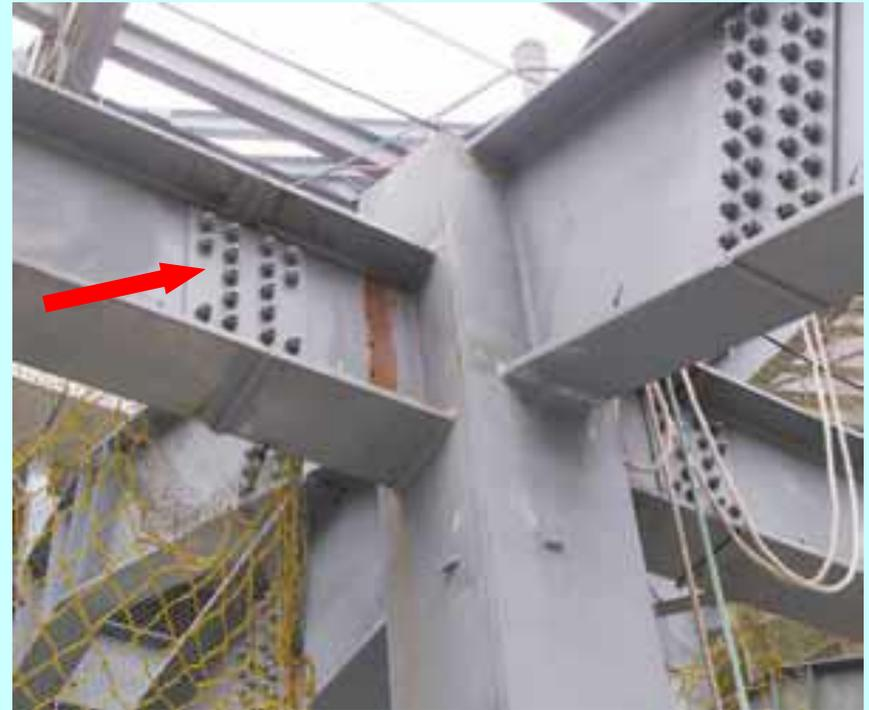
降低接頭處應力集中的現象，可有效改善傳統鋼結構常因地震力所導致在梁柱接頭內斷裂的情形，可提高結構物之安全性
