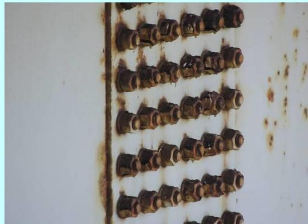
補救措施→螺栓以溶劑除油或電動鋼刷除銹後，塗裝方式除最後一道面漆外均須採人工塗刷
