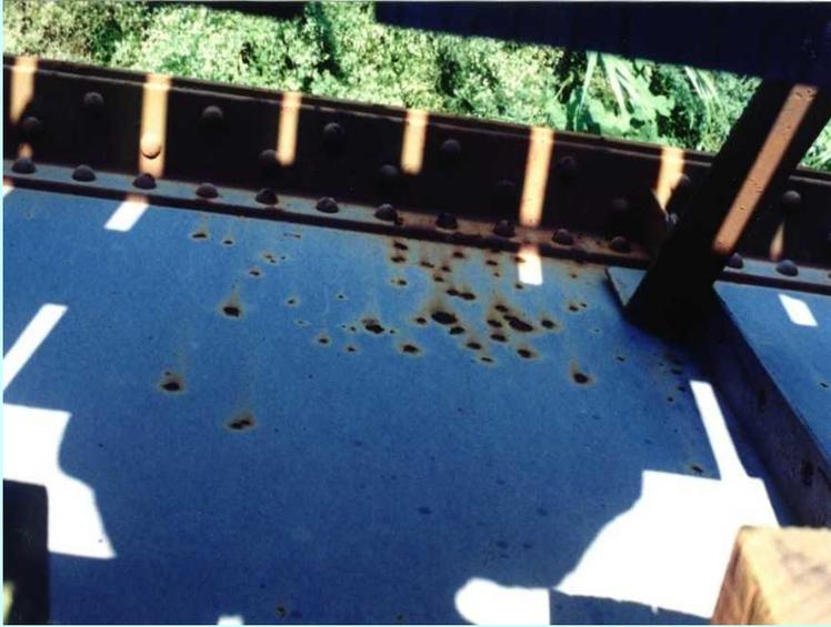
鋼梁表面塗膜劣化，孔蝕
