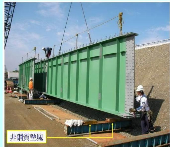
缺失態樣：構件與構件或構件與連接板間之縫隙所產生之間隙腐蝕
