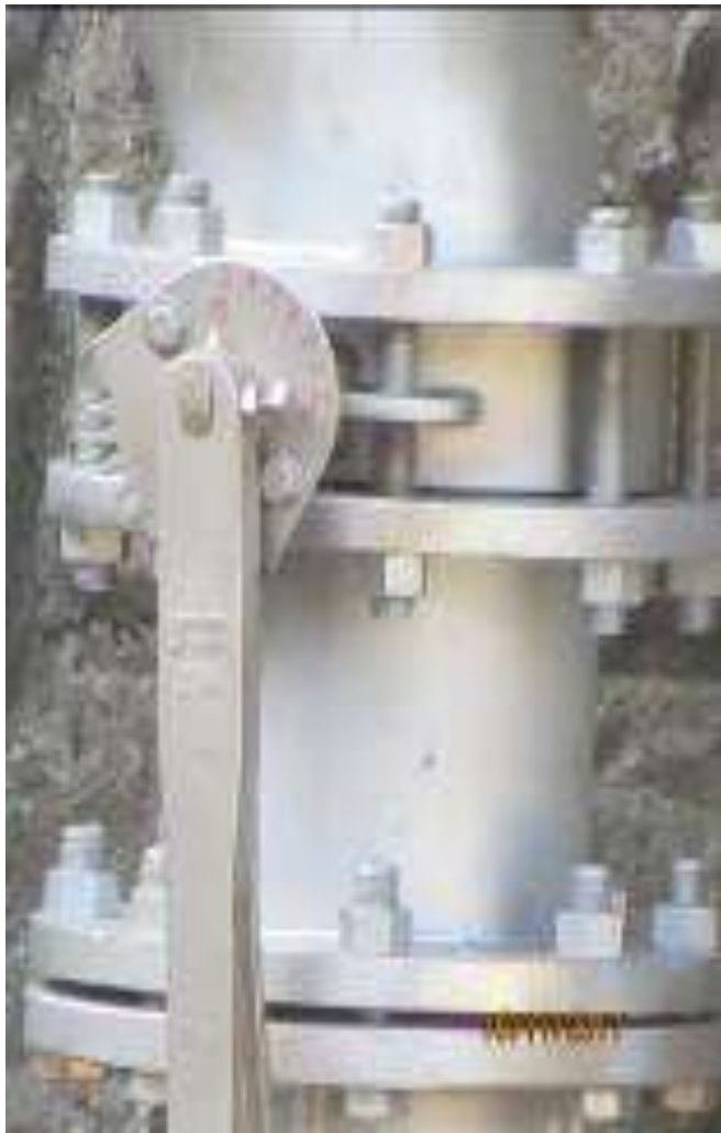
突緣固定螺栓未裝墊片
