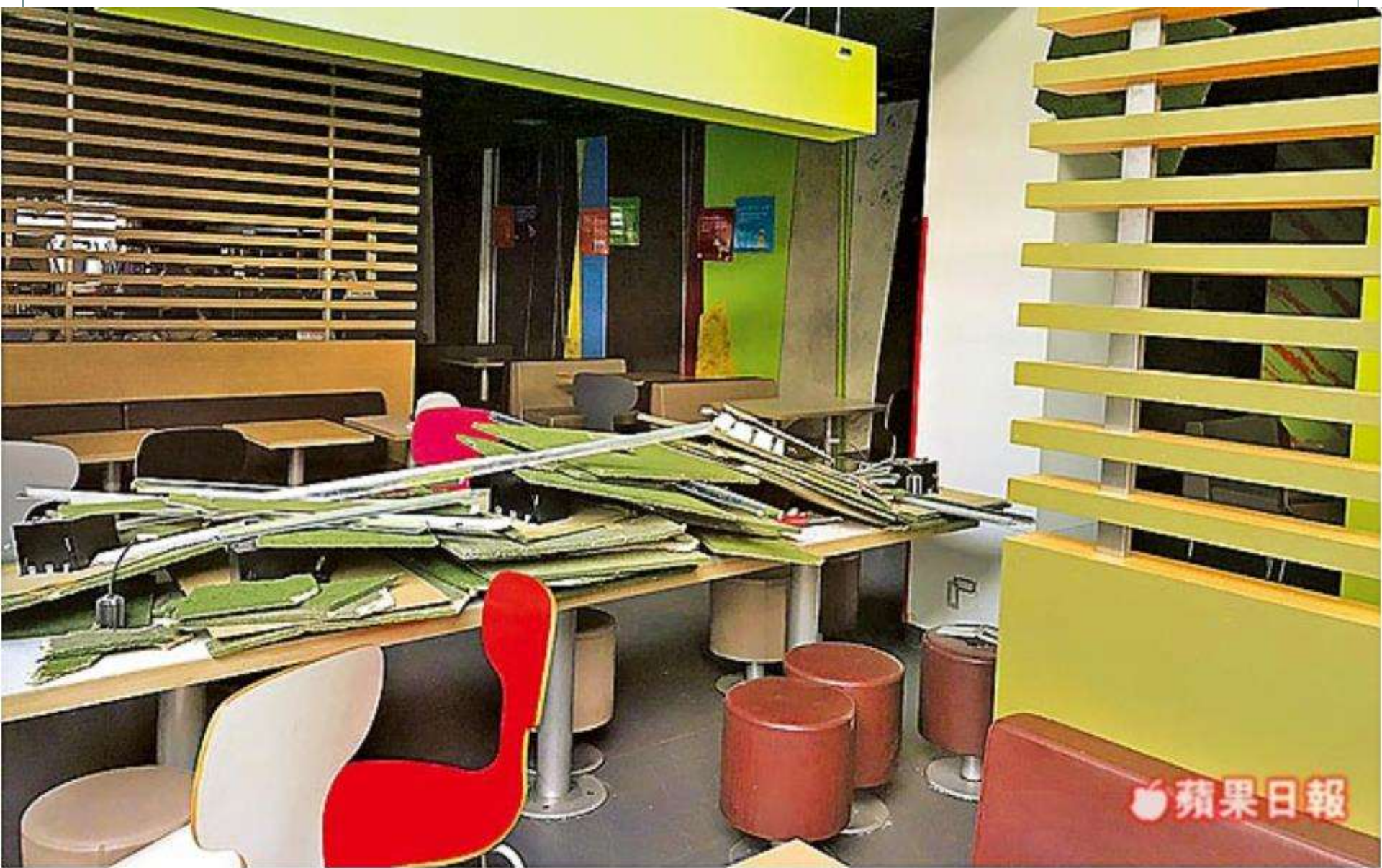
掉落的輕鋼架天花板，砸中正在用餐的消費者，並散落桌上。翻攝畫面
