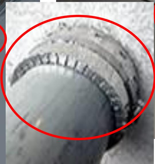
穿過防災區劃(樓板、牆壁、天花板、隔間牆等)之電纜架及匯流排系統，應加裝防火塞物或防火帶隔絕之
