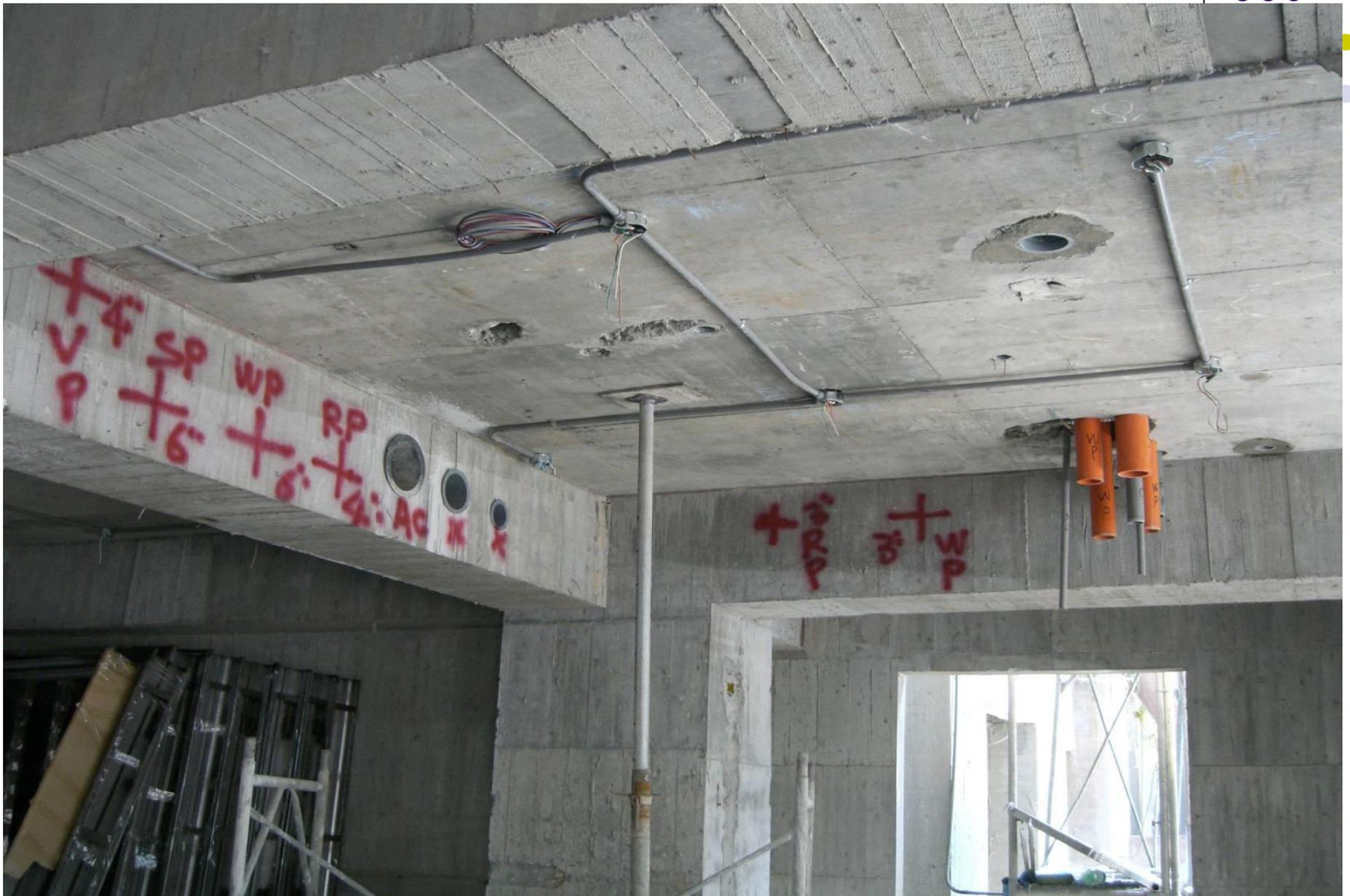
建築與設備穿梁孔未做圖面整合
